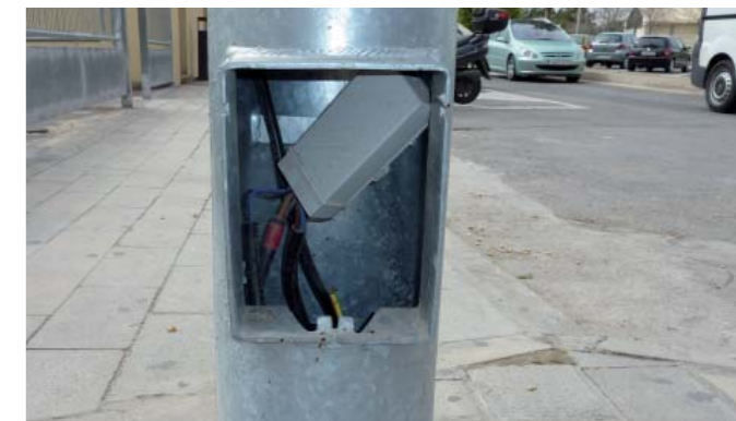
Imagen 4. Báculo de un alumbrado exterior sin portezuela. Posibilidad de contacto directo con un viandante
