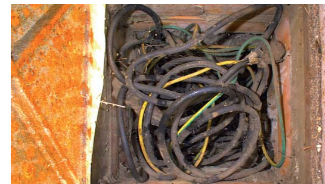
Imagen 5. Arqueta de un alumbrado exterior sin cinta de vulcanizado y con humedad, mal drenaje y sin obturar los tubos.
