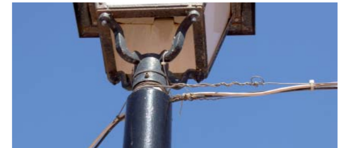
Imagen 8. Conductor sin aislamiento de 0'6/1 Kv posado y alimentando alumbrado exterior. Posibilidad de contacto directo e indirecto.
