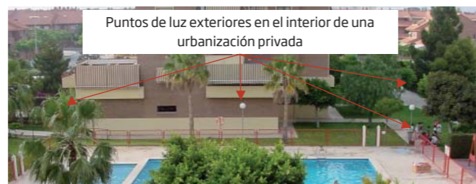
Imagen 1 . Interior de una urbanización en la cual el alumbrado interior tiene la consideración de exterior. Según el REBT'02 ITC - BT 09.
