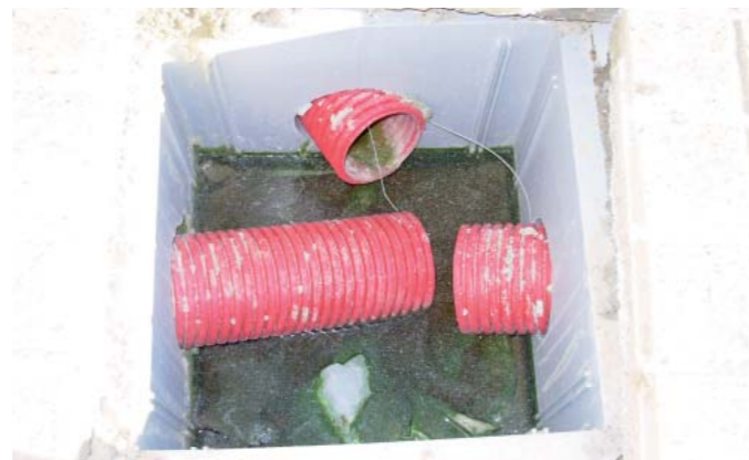
Imagen 7. Arqueta mal construida. Antes de poner los conductores, bajo la acción de la lluvia, la arqueta no drena.
