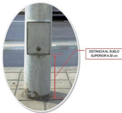
Imagen 3. Algunos fallos en algunos alumbrados exteriores vienen de que la portezuela está a menos de 30 cm, con lo cual a veces penetra el agua de lluvia.
